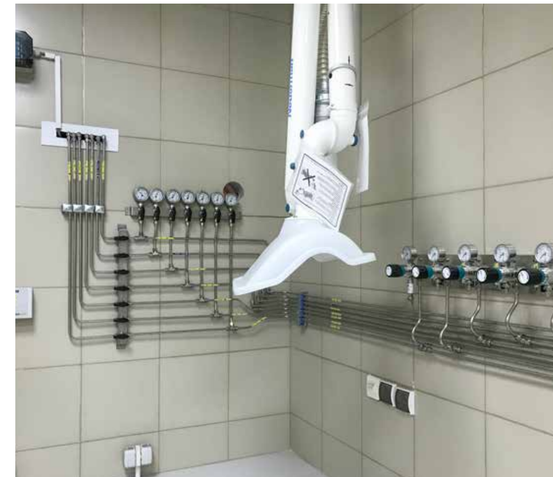
رگلاتورهای نقطه مصرف و Valve Box ↑
